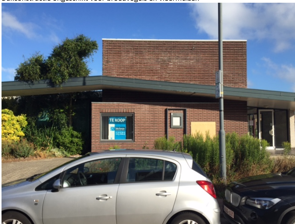
Geen open stootvoegen in de lage bebouwing: geen functie voor vleermuizen.
