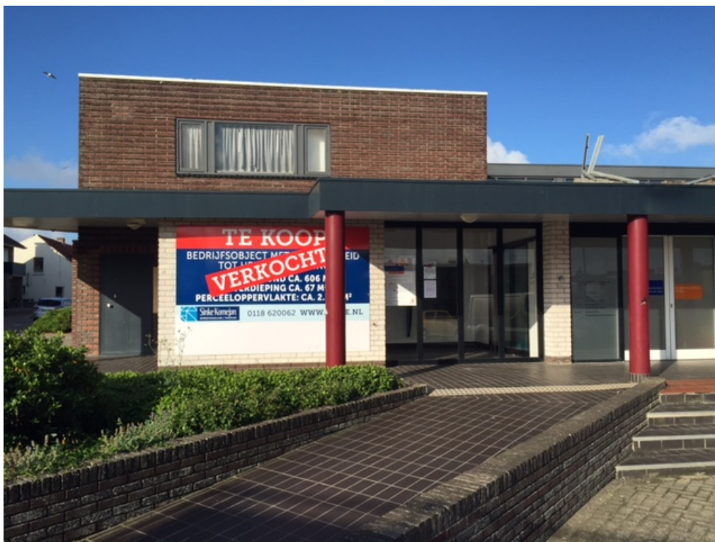
Dakconstructie ongeschikt voor broedvogels en vleermuizen
