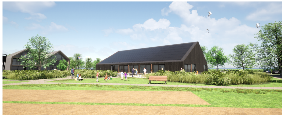
Gemetselde plint met houten delen als gevel en metalen dak met zonnepanelen.
