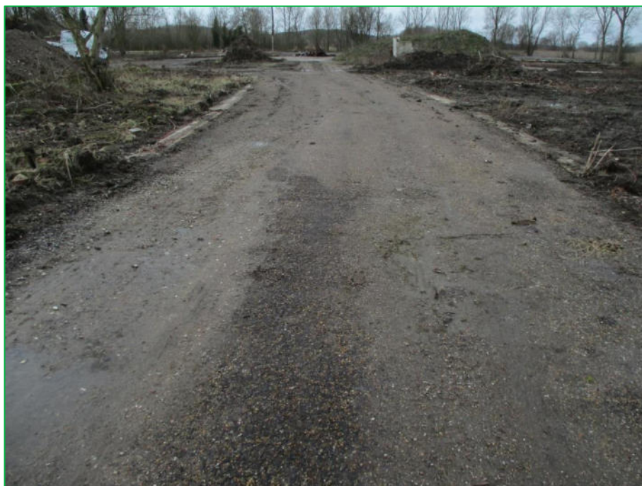
Foto 22 Asfaltoprit toegang van het terrein, richting westen
