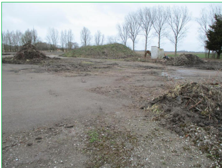
Foto 26 Asphaltverharding op het terrein, richting noordwesten
