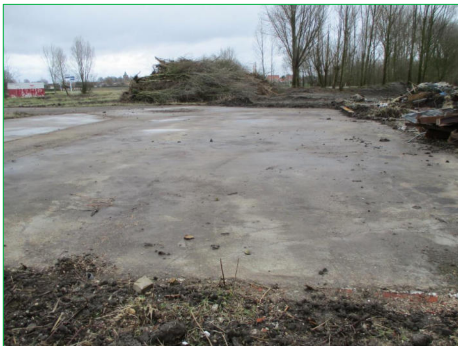
Foto 18 Beton met vliegas en ligging voormalige ondergrondse tank, richting zuiden
