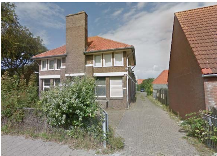
Figuur 1.2 Foto voorzijde KPN-gebouw Schelpweg 8 (bron: google street view)
