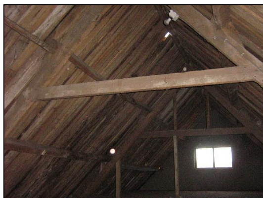
Dakconstructie schuur duinweg
