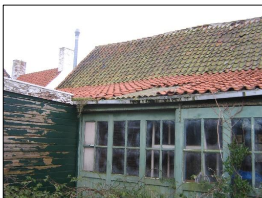
Dak achterzijde schuur Duinweg
