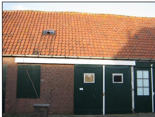
Gevel schuur aan Duinweg
