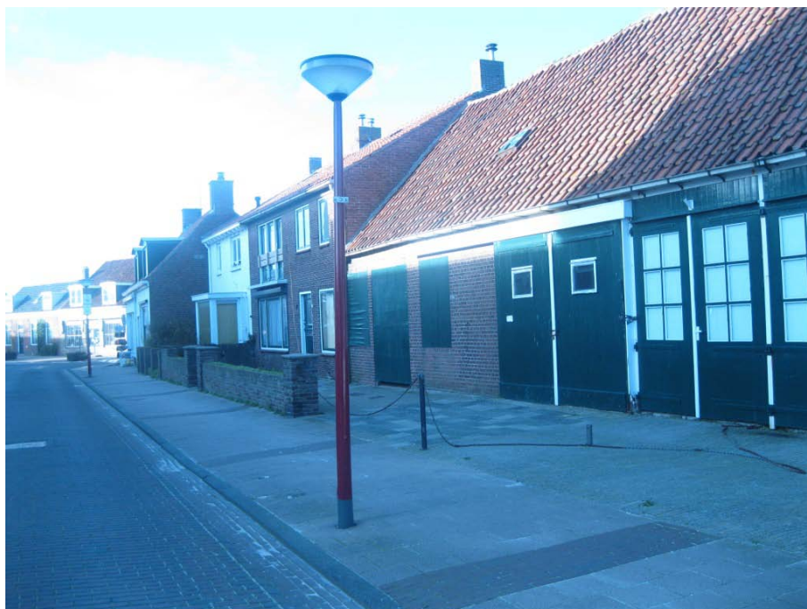
IMG_4946, aan de Duinweg 9, 7, 5 en 3 (van rechts naar links gezien).
