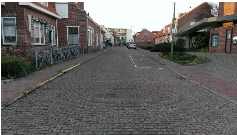
Figuur 1: Wegbreedte Langendam (t.h.v. huisnr. 20) = 3,5 meter / parkeerplaats is 2,10 meter breed
