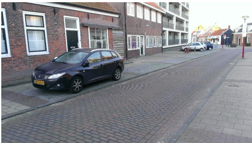
Figuur 3: Wegbreedte Duinweg (t.h.v. huisnr. 7) = 3,30 meter / parkeerplaats is 1.85 meter breed
