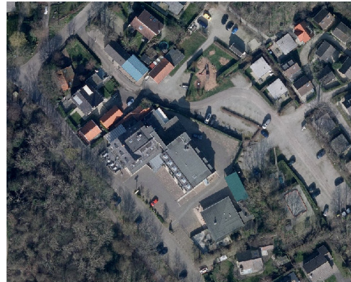
Figuur 1, situatie(bron: geoweb)
