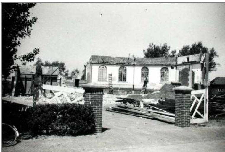
Figuur 18: Sloop van de Gereformeerde Kerk aan de Bergstraat in 1962 (Bron: Beeldbank Zeeland, 2014)
