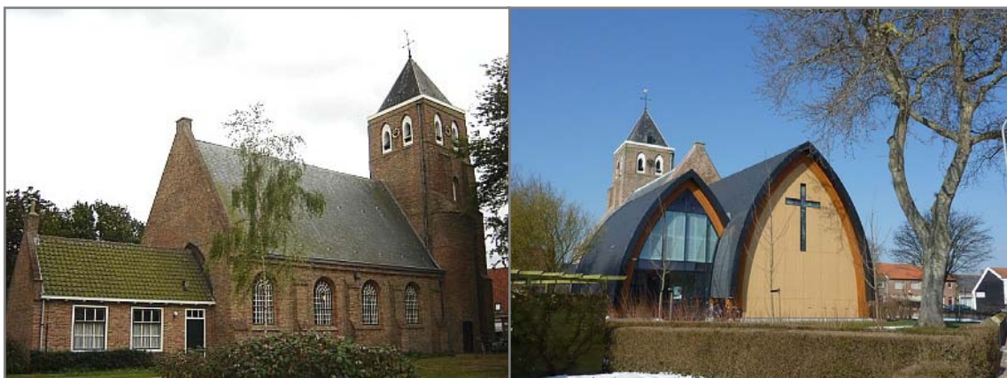
Figuur 15: De Odulphuskerk inclusief consistorie vóór 2012 – links – en de Odulphuskerk met nieuwbouw na 2012 (Bron: Orgels in Zeeland & Wikipedia , 2014)
