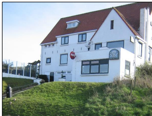
Noordgevel bestaand Duinhotel Tien Torens
