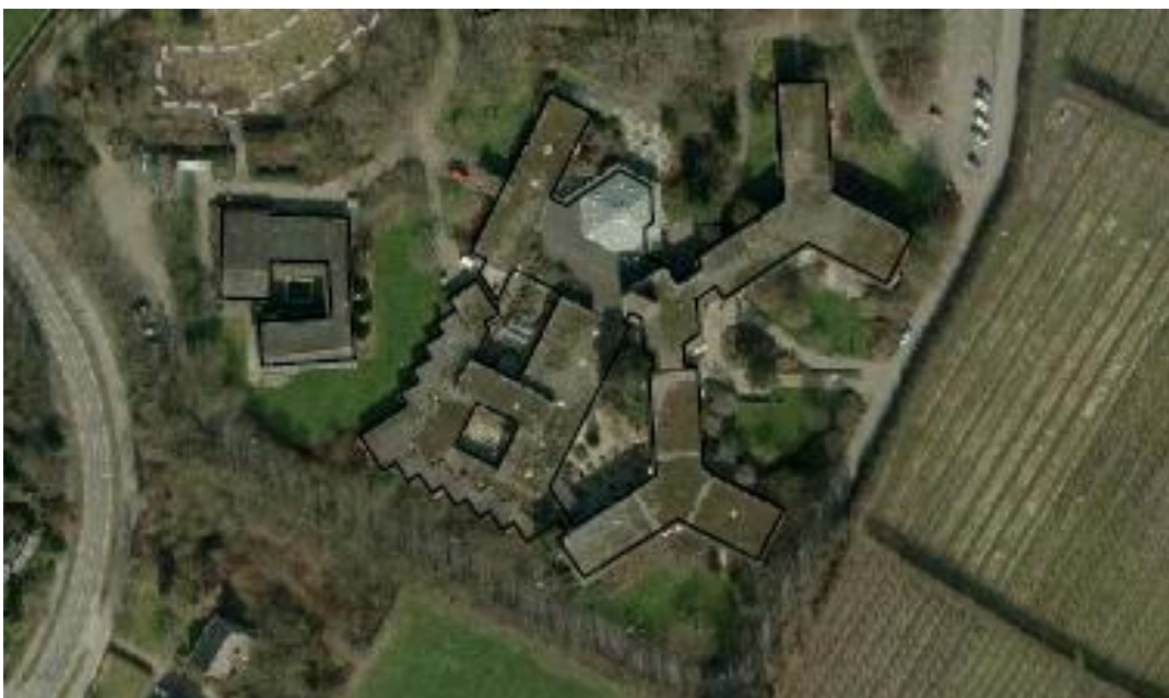
Figuur 4: Te slopen bebouwing
