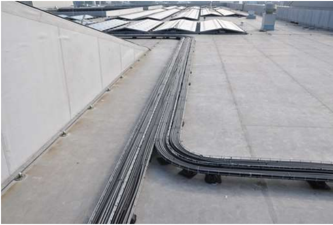
Afbeelding 1.2 Kabeltracé met transportkabels (Bron: TBO GM)
