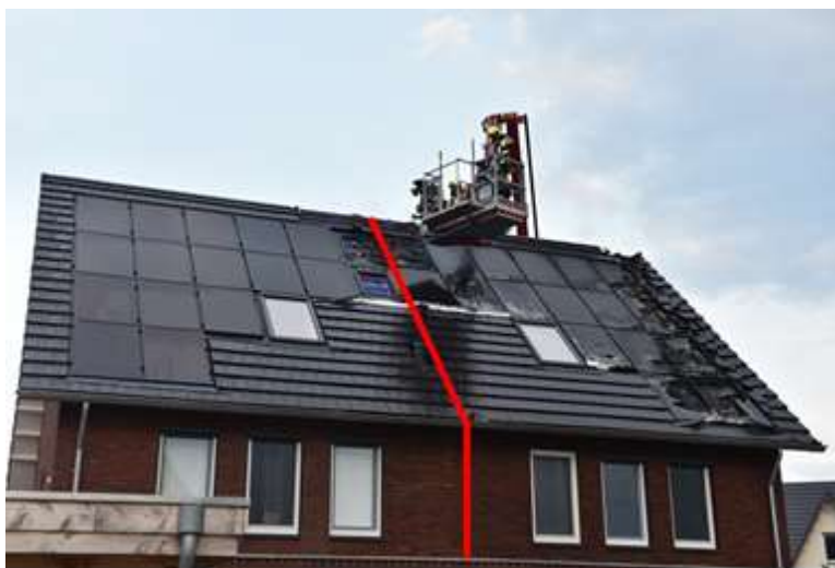
Afbeelding 3.3 Branduitbreiding over de brandscheiding heen. De panlatten zijn conform regels. Rechts: detail; dakpannen onderbroken (Bron: Tbo GM)
