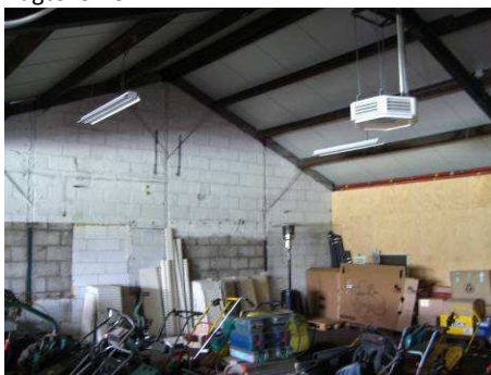
Binnenzijde van het bedrijfspan (opslagloods).
