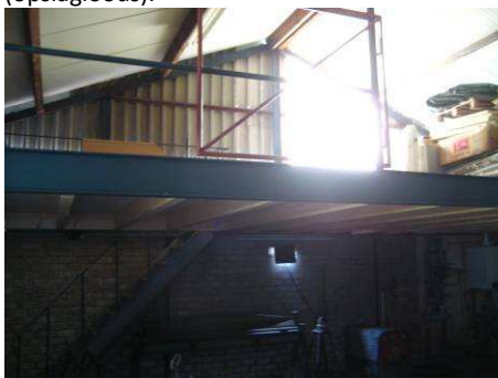
Binnenzijde van het bedrijfspan (opslagloods).
