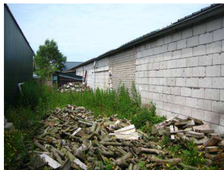
Westzijde van het bedrijfspan.
