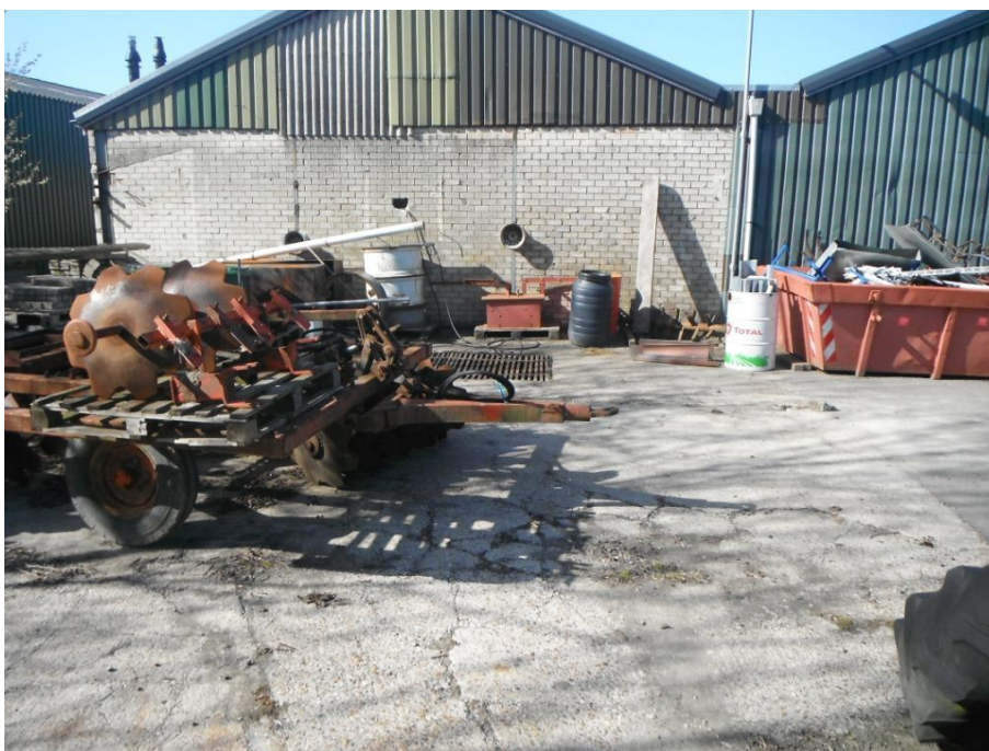
DSCF1514, locatie voormalige bovengrondse opslagtanks olieproducten/wasplaats/ oliewaterscheider gezien in noordelijke richting.
