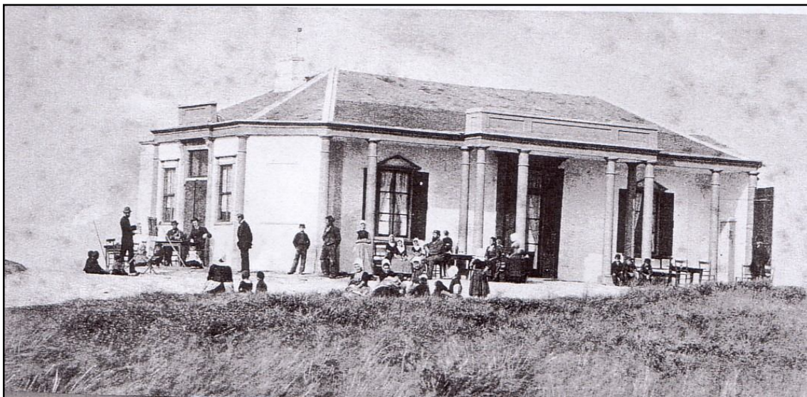
Figuur 17: Het voormalig Badpaviljoen, gebouwd in 1837, enkele jaren voor de sloop (Bron: Warners, J. 1984)
