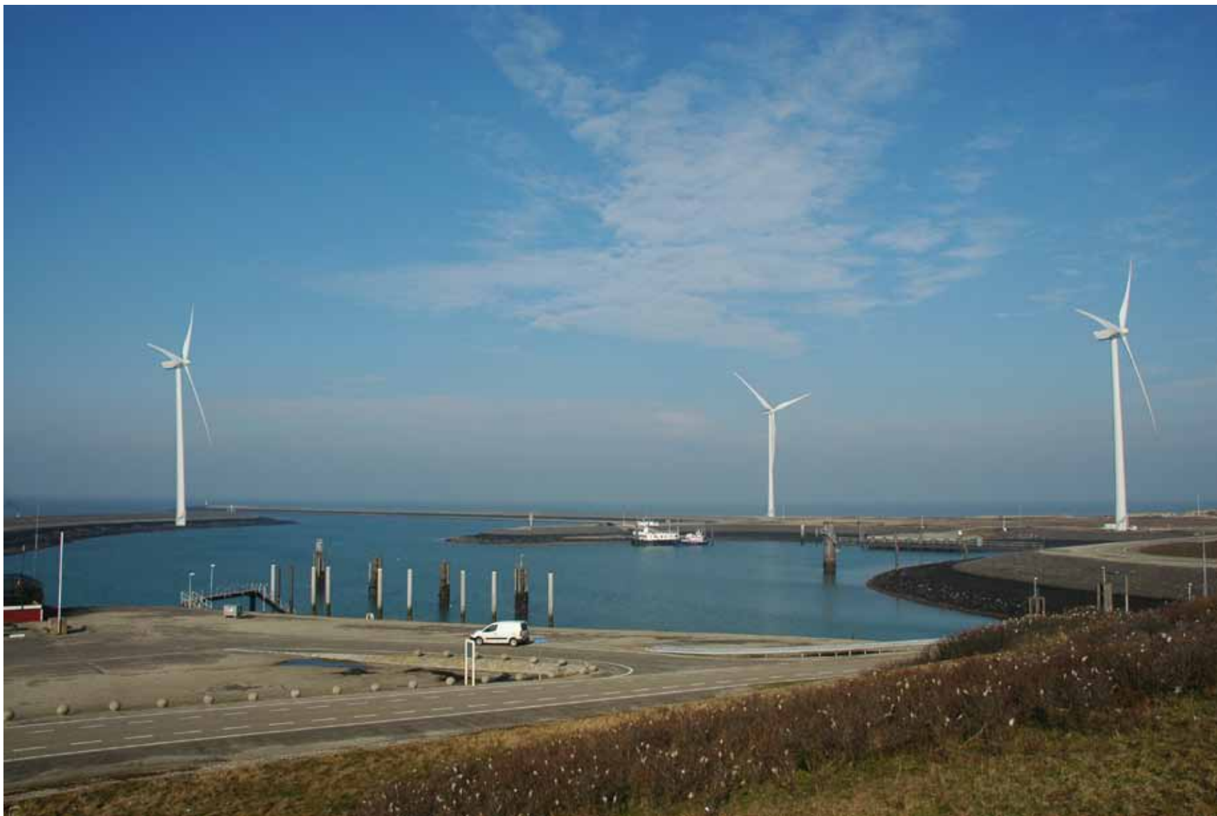
situatie strekdam vanaf N57 met nog te plaatsen windturbine
