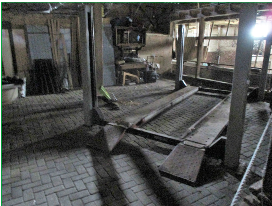
Foto 4: Weegbrug inpandig in de grote schuur
