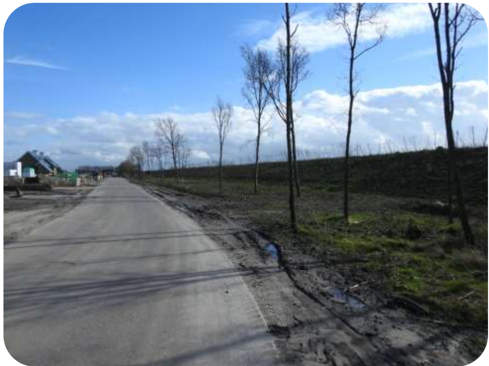
Afbeelding 10, De geluidwal gezien vanaf Resort Waterrijk.
