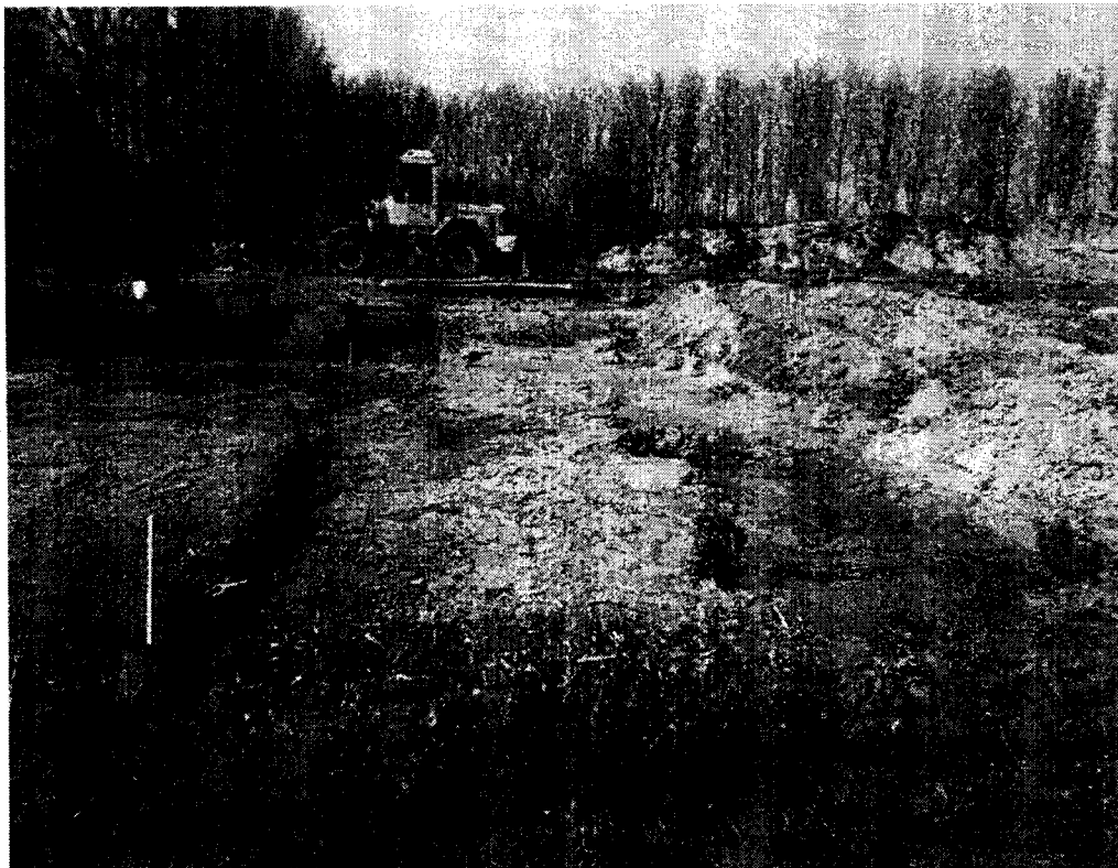
Foto 7: ontgraving gedeelte voormalige stortplaats (gezien in westelijke richting)
