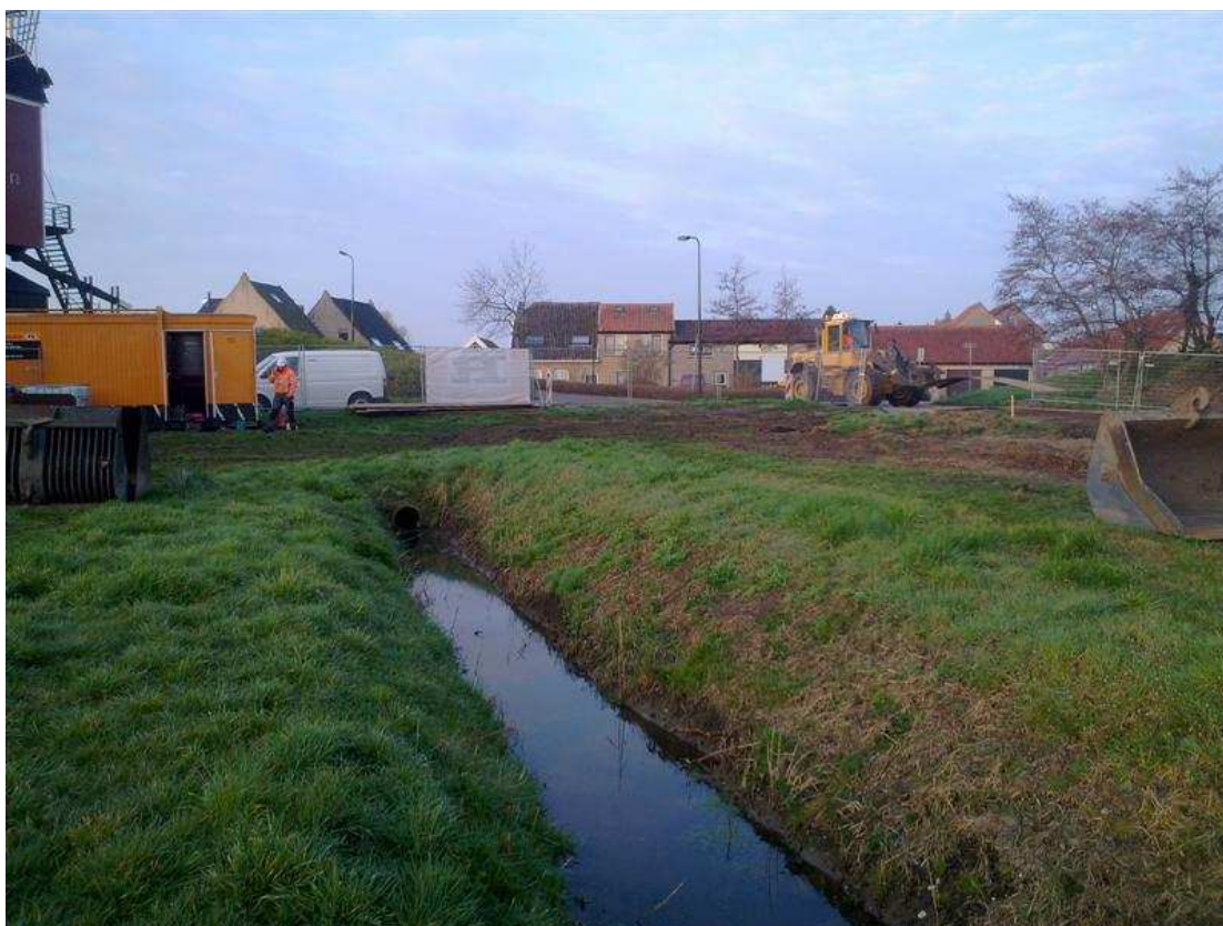
Foto 2: situatie bij aanvang bodemsanering gezien in noordoostelijke richting
