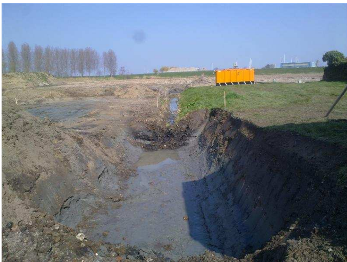
Foto 5: ontgraving van zuidelijke gedempte sloot (gezien in noordoostelijke richting)
