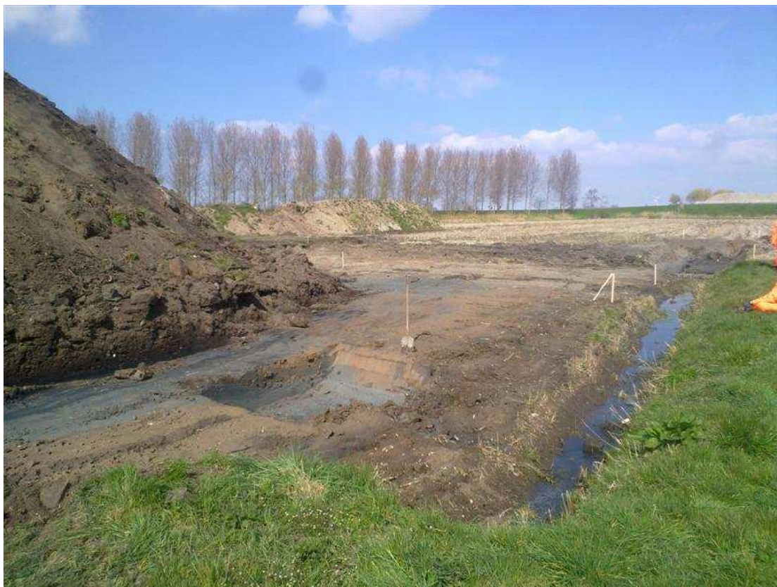
Foto 4: gedeeltelijk ontgraven gedeelte voormalige stortplaats
