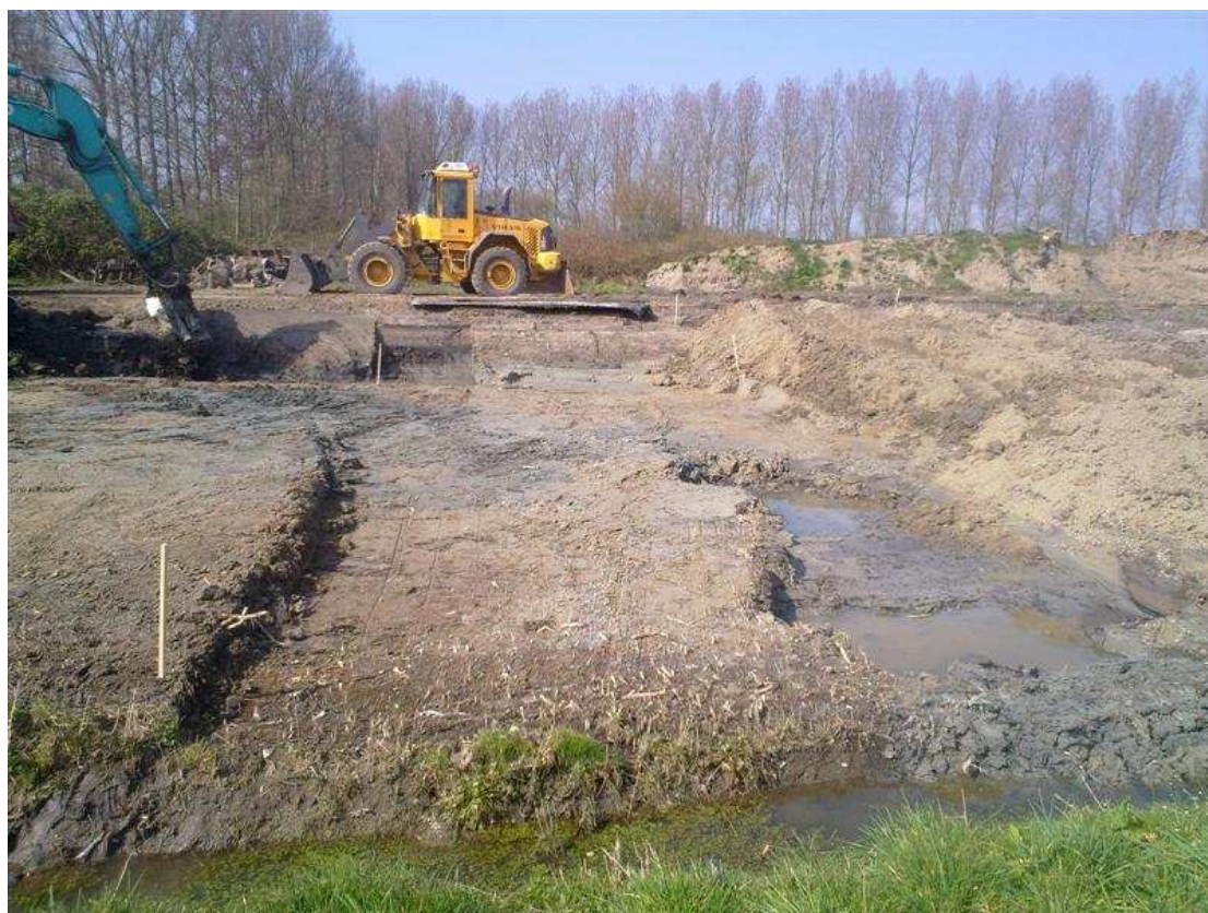
Foto 7: ontgraving gedeelte voormalige stortplaats (gezien in westelijke richting)
