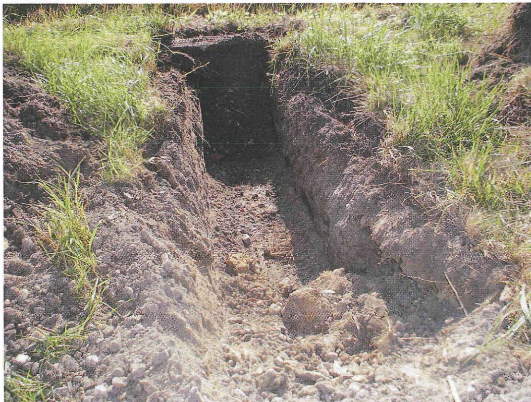
Foto 2: aanzicht afbakeningssleuf A5
