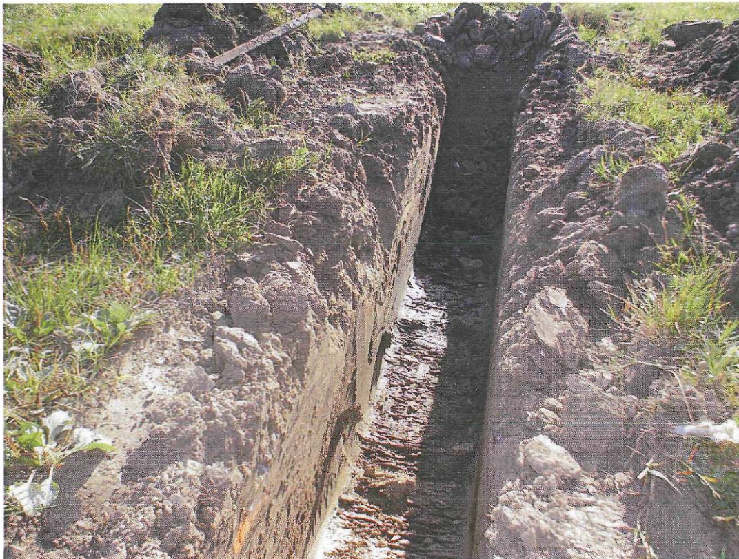
Foto 1: aanzicht afbakeningssleuf A4
