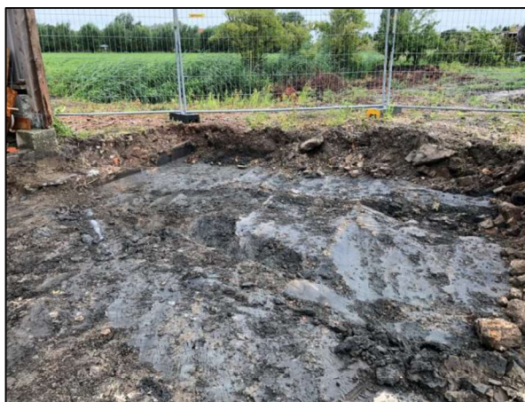
Foto 4: Eindsituatie wand WPU-1 na saneringswerkzaamheden
