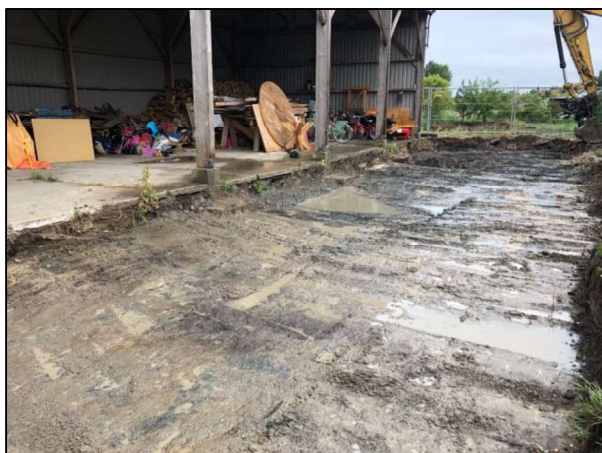
Foto 3: Eindsituatie na saneringswerkzaamheden
