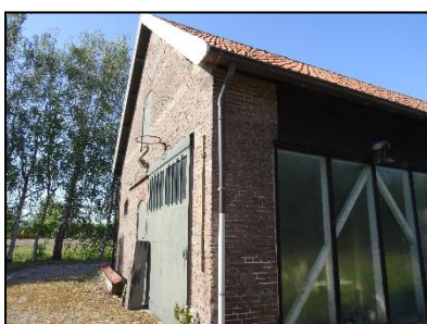
Figuur 22. Westzijde woning met ruimte onder dakrand, betimmering en dakpannen (9 in figuur 3).
