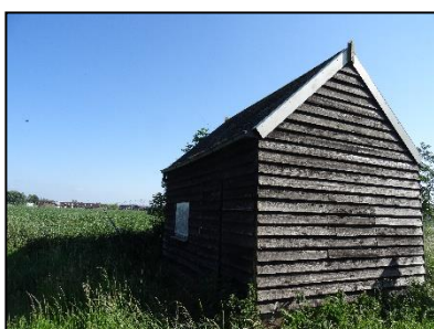
Figuur 23. Schuurtje met ruimte achter dakrand (4 in figuur 3).
