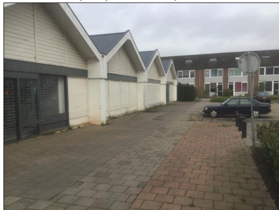
Foto 2: Oostelijke zijde (d.d. 04 april 2019)
