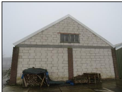
Figuur 10. Noordzijde van de derde schuur van pand 3.
