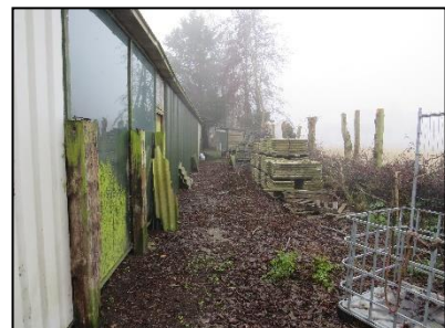
Figuur 14. Westzijde van de schuur van pand 4.
