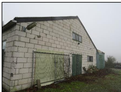
Figuur 13. Zuidzijde van de schuur van pand 4.
