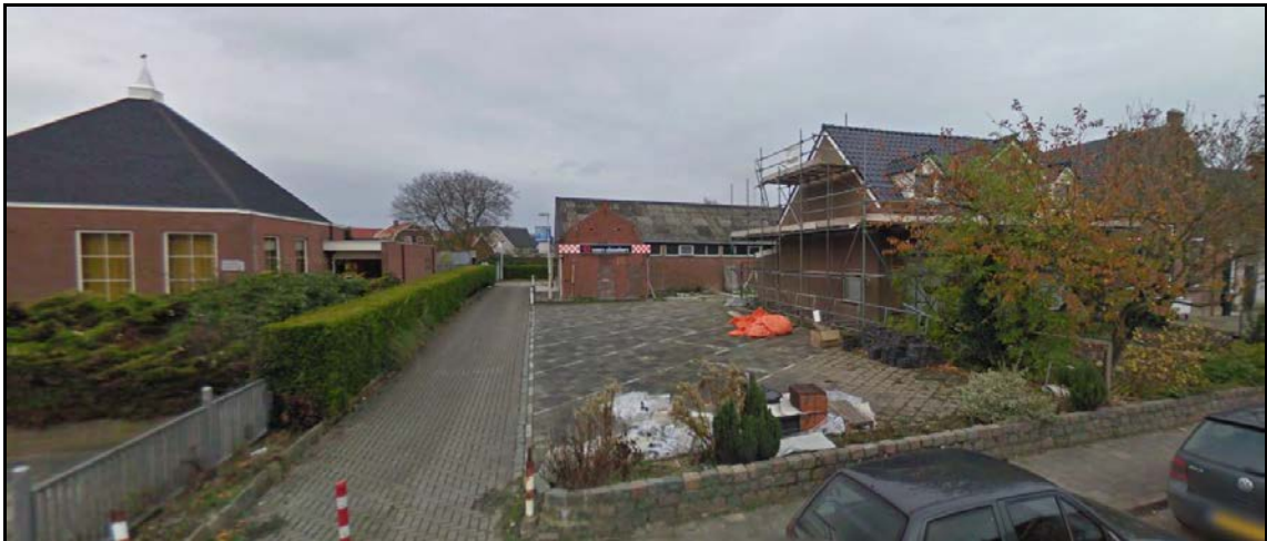
Afbeelding 4: Zicht op het plangebied, met op de achtergrond het bedrijfspand.
