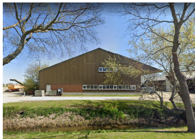
Bestaande loods gezien vanaf de Lange Zandweg (geen singel aanwezig) (bron Google Maps, april 2021)
