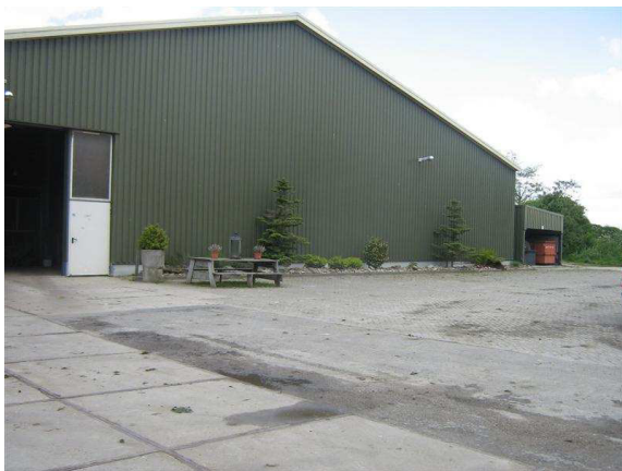
foto 1: aanzicht nieuwe schuur (noordoostelijke richting)
