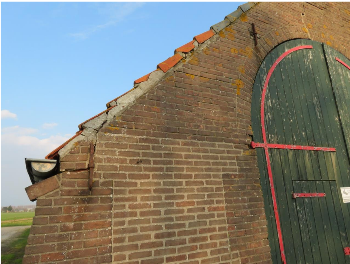
Met cement vastgezette nok- en kantpannen.
