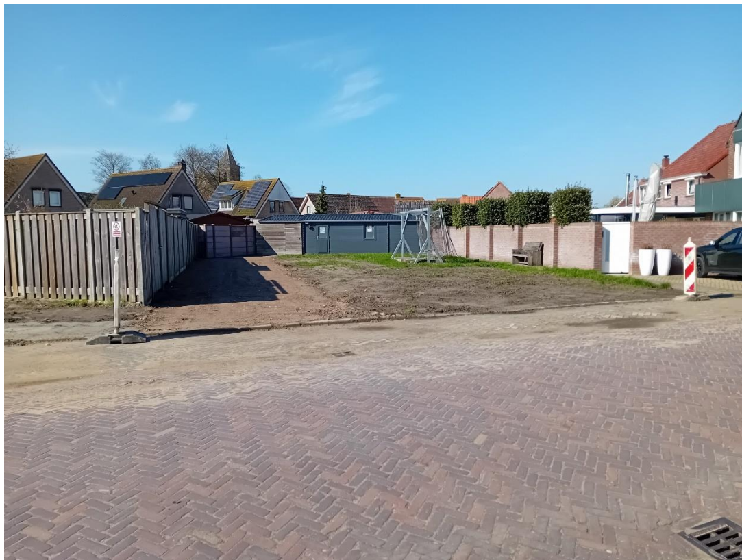
Braakliggend terrein langs de Paasdijkstraat waar garageboxen gerealiseerd worden. Foto: J. Keyzer | Ecoresult B.V.
