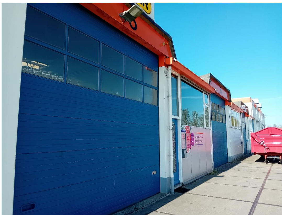
Impressie van de gevel aan de oostzijde van het plangebied. Foto: J. Keyzer | Ecoresult B.V.
