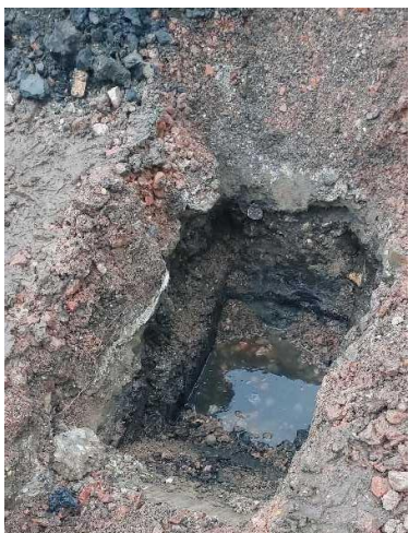
Afbeelding 3: PG4 met gebroken baksteenpuin en onderliggende laag met puin, asfalt, baksteen en kleilagen
