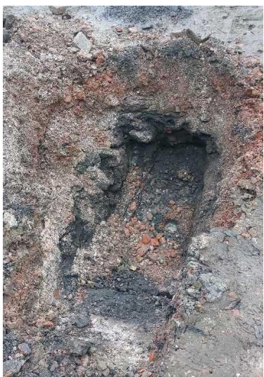
Afbeelding 5: PG5 met gebroken baksteenpuin en onderliggende laag met puin, asfalt, baksteen en kleilagen
