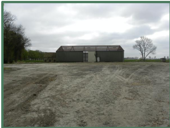
Foto 1: Overzicht plangebied vanaf het noorden.
