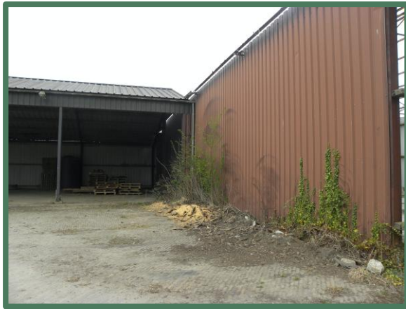
Foto 3: Zuidelijke gevel van bebouwing met aangrenzende loods.
