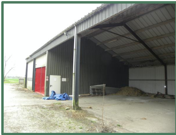
Foto 5: Overzicht loods vanaf het noordoosten.
