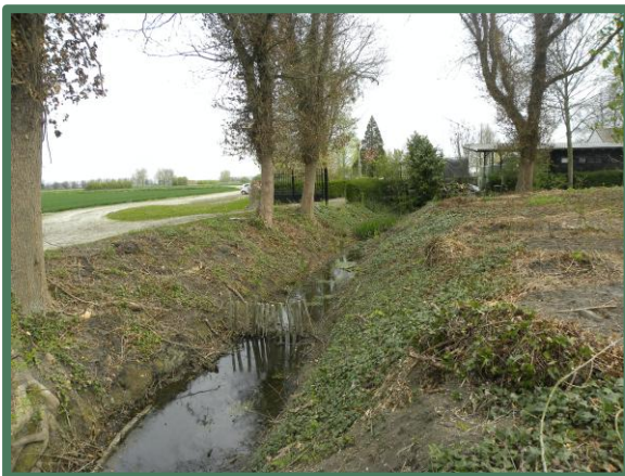
Foto 19: Sloop aan de noordzijde, vanaf het westen.
