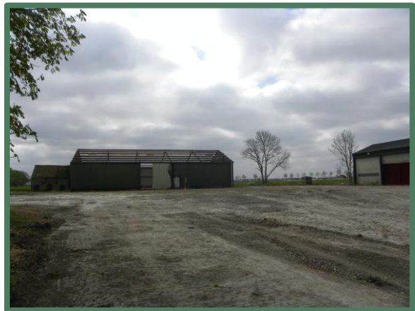
Foto 18: Overzicht plangebied vanaf het noorden.
