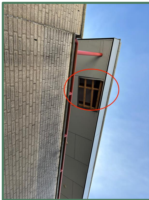
Gat in het trespa dak
