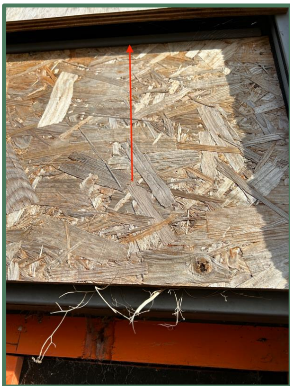
Met een pijl aangegeven: opening tot de betimmering
