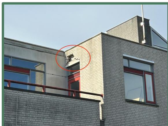
Gat in de spouwmuur
