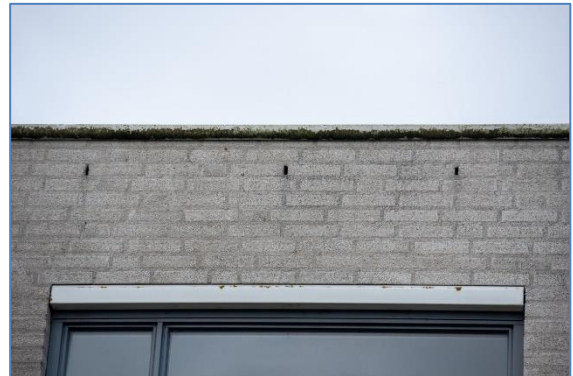
Foto 8: Open stootvoeg biedt toegang tot ruimte daarachter voor een vleermuisverblijf.
