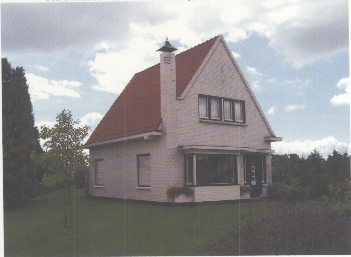
Foto 1. Overzicht onderzoekslocatie d.d. 31 juli 2007 in zuidwestelijke richting
