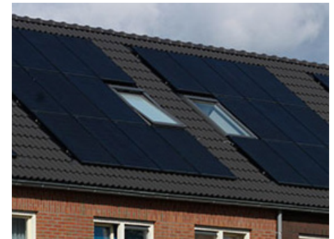
voorbeeld PV panelen met dakraam
