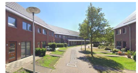
geknikte straat met begeleidende gevels
