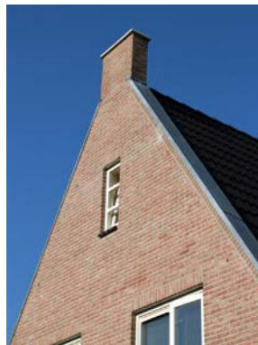
gevel voor dakvlak
