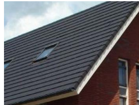
voorbeeld dak met vlakke moderne dakpan
