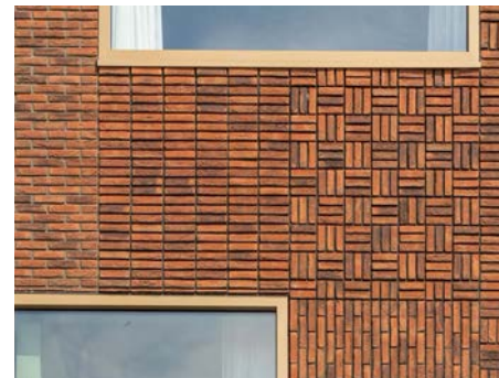
voorbeeld diverse metselwerkverbanden
