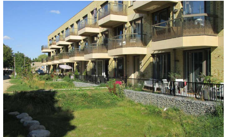
wadi met keerwand bij privé buitenruimtes
