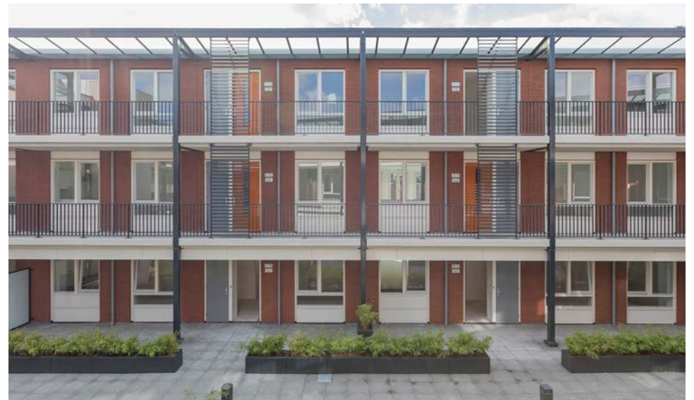
appartementengebouw 3 lagen galerij zijde
