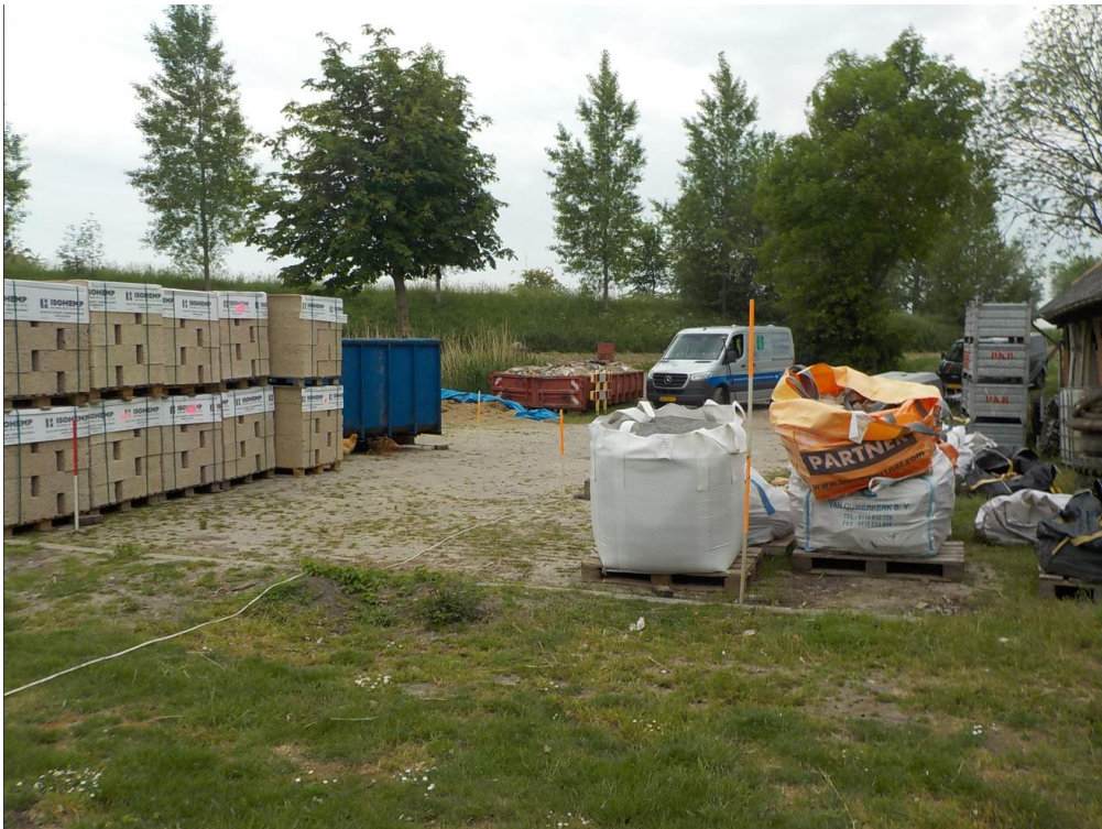
Foto 3: Boringen 17 en 201 t/m 204
