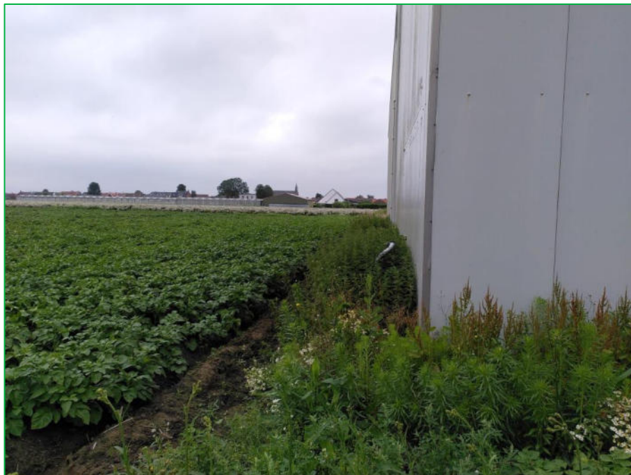
Foto 3 Noordzijde loods, landbouwperceel ten noorden, richting oosten
