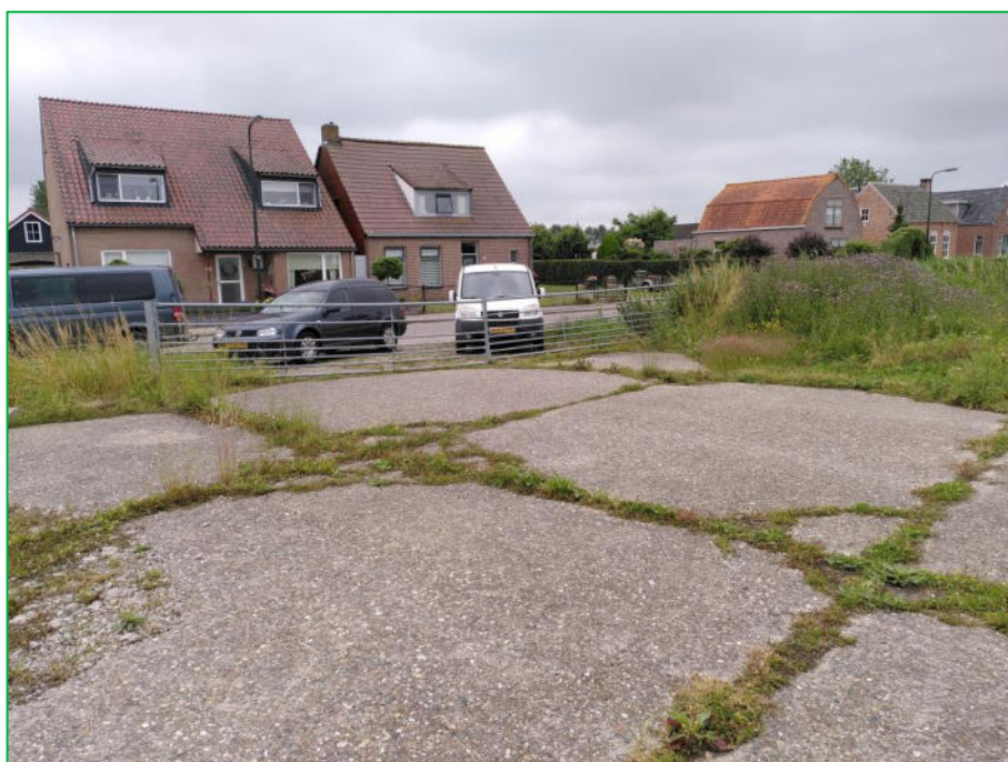
Foto 6 Voorterrein loods, richting zuidwesten
