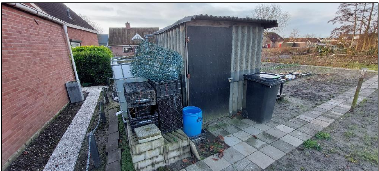
Figuur 4: Overzichtsfoto 3 asbestverdachte locatie (AMM1).
