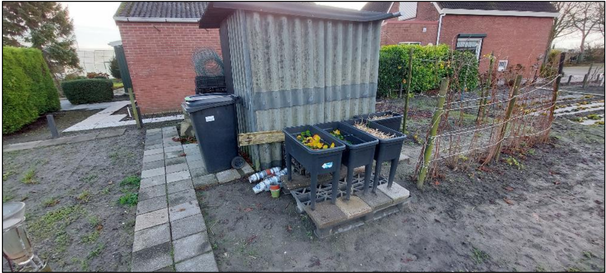
Figuur 5: Overzichtsfoto 4 asbestverdachte locatie (AMM1).
