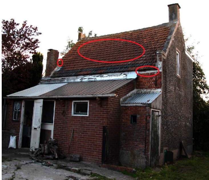
Foto 2: Overzicht potentiële locaties zomerverblijf onder dakpannen en loodslap schoorsteen en spleet onder de dakrand
