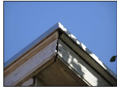
Figuur 26. Spleten onder de dakrand.
