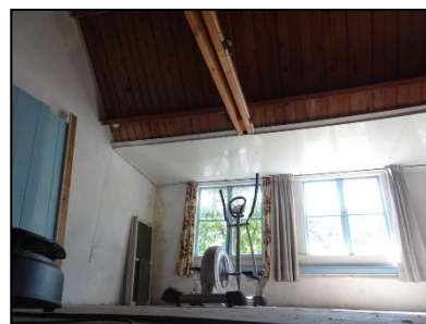
Figuur 11. De eerste verdieping van de woning met kijkrichting naar het westen.
