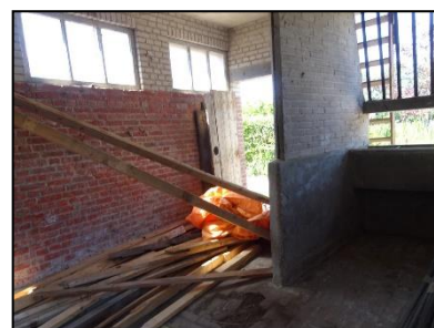
Figuur 20. De binnenkant van de schuur.
