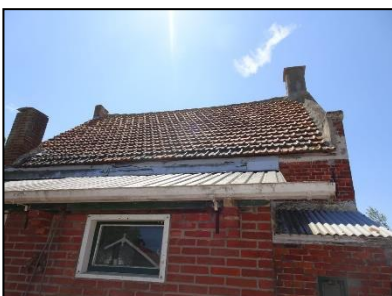
Figuur 16. De achtergevel van de woning.
