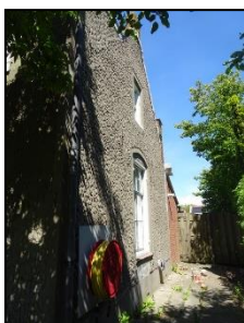
Figuur 15. De zijgevel gelegen aan de zuidzijde van de woning.
