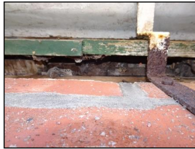
Figuur 25. Ruimte tussen de muur en de betimmering van de woning.
