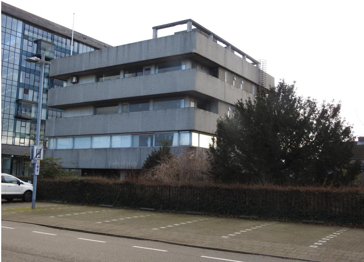
Foto 1. Te slopen bebouwing.
