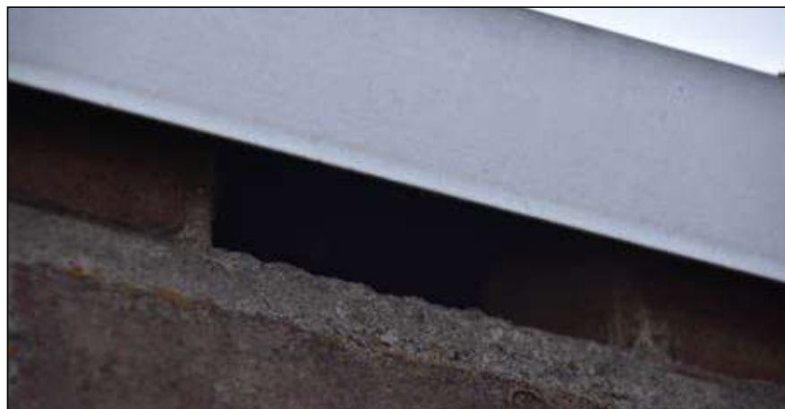
Figuur: de dakrand van de garageboxen. Hier zijn enkele openingen die mogelijk als verblijfplaats voor vleermuizen dienen.
