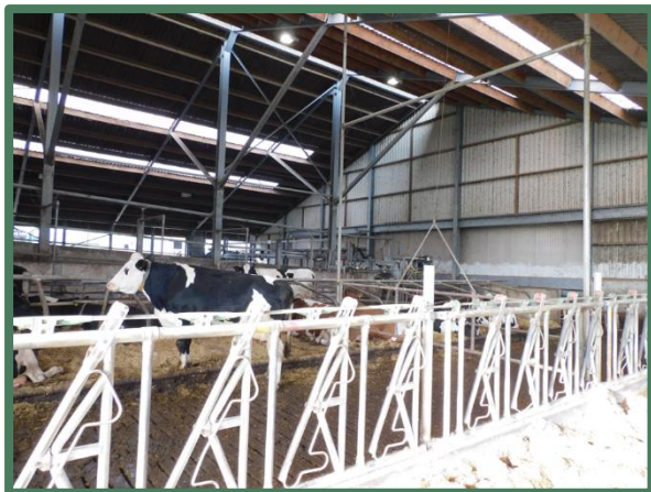
Niet geïsoleerde of onderschoten daken en wanden in stallen
