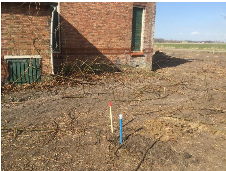
Foto 7 Peilbuis tussen de woning en de schuur
