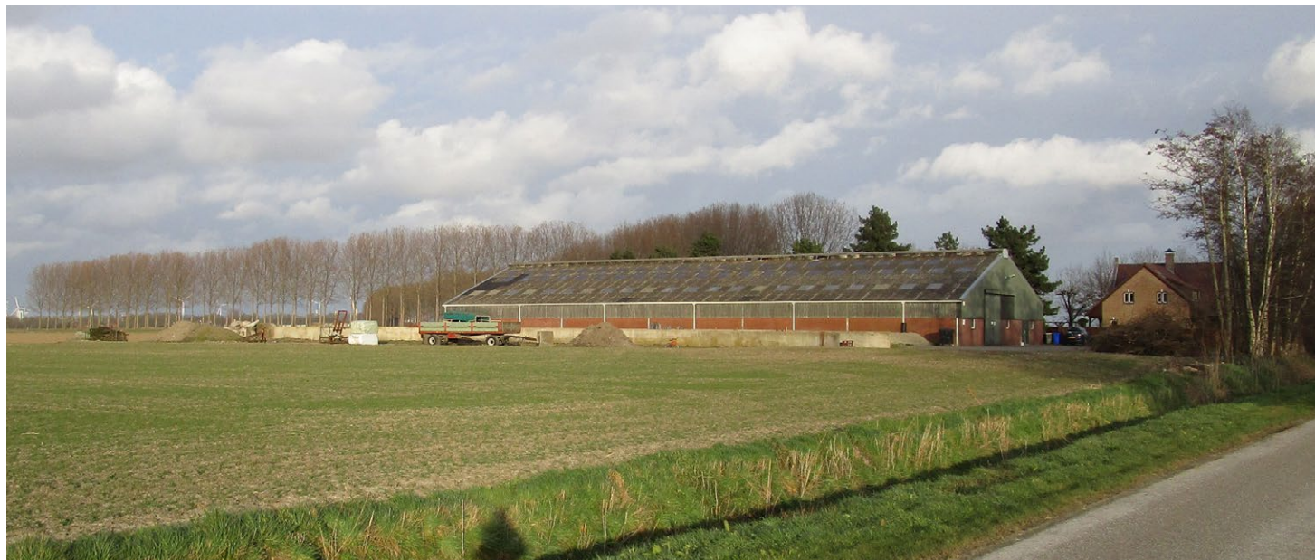
De oude koeienstal gezien vanuit westelijke richting.
