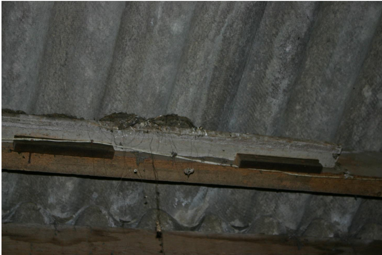
Figuur 4.4.2. In het te slopen deel van het bijgebouw zijn twee boerenzwaluwnesten waargenomen waarvan er één in gebruik is.
