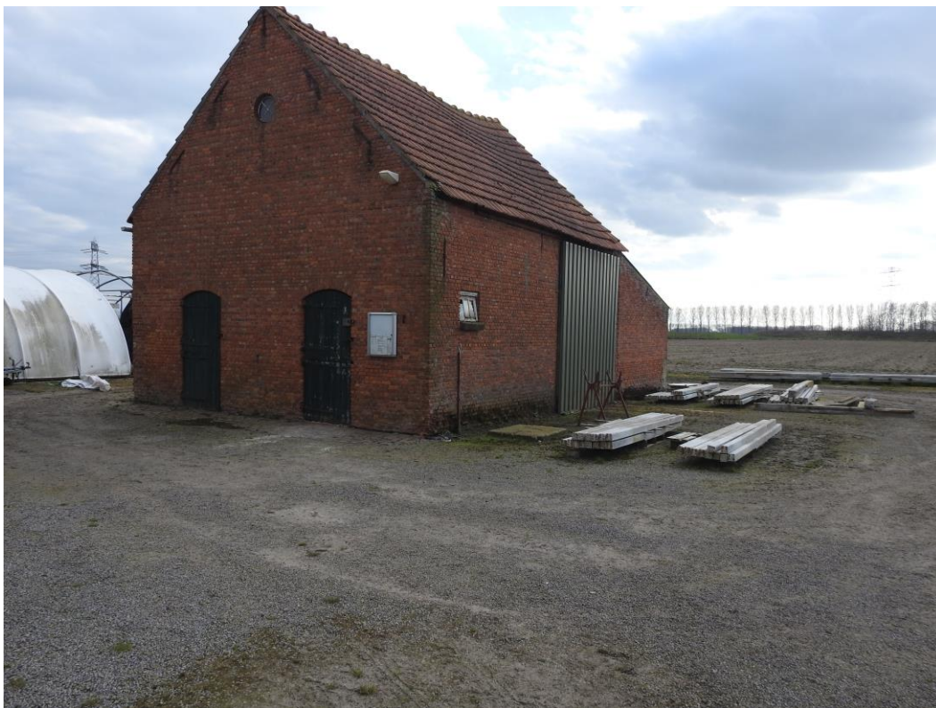
Foto 2. Plangebied, te slopen schuur.
