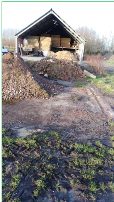
Foto 1. Oude betonvloer incl. puindepots
