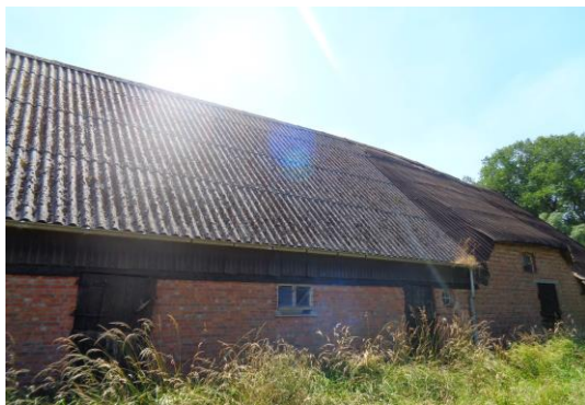
Asbesthoudende beplating
