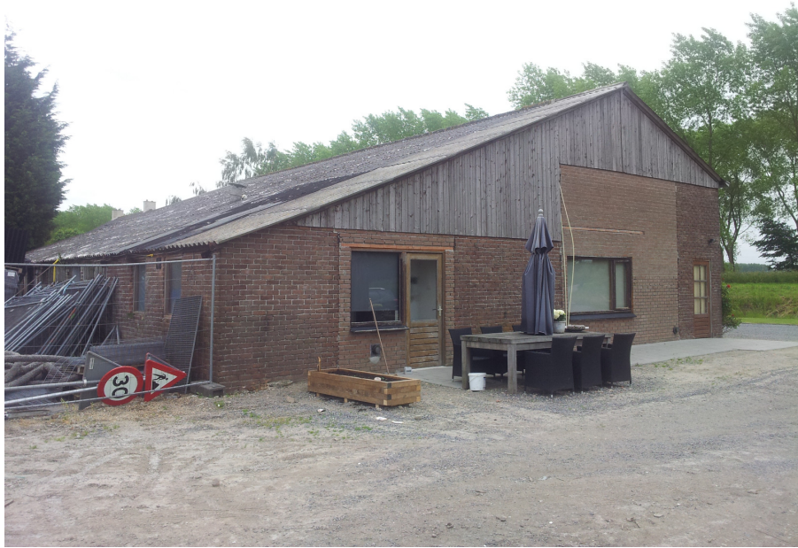
Figuur 2.10: aanzicht te slopen bedrijfsgebouw met veestal
