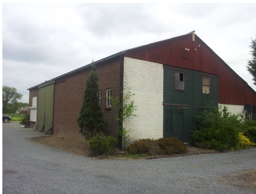
Figuur 2.12: aanzicht te slopen bedrijfsgebouw met veestal
