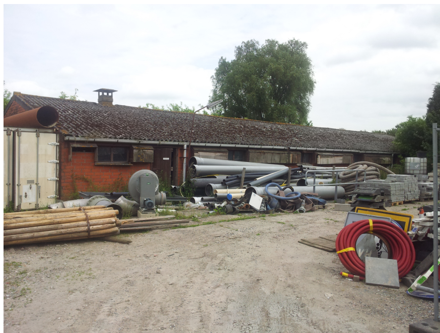
Figuur 2.9: aanzicht te slopen veestal
