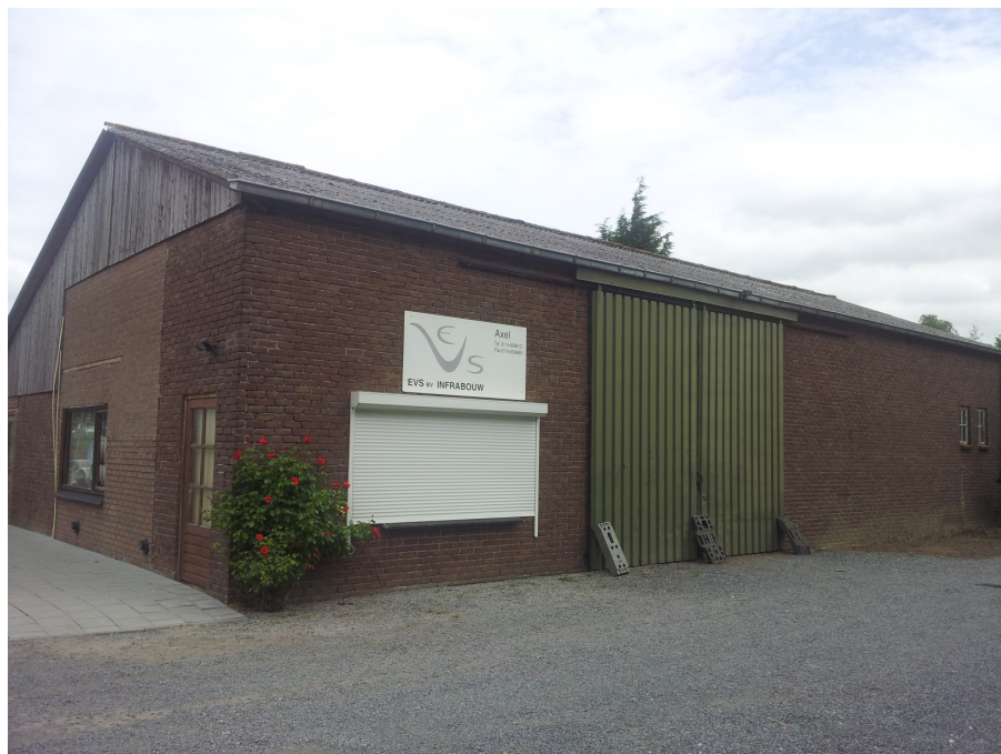
Figuur 2.11: aanzicht te slopen bedrijfsgebouw met veestal
