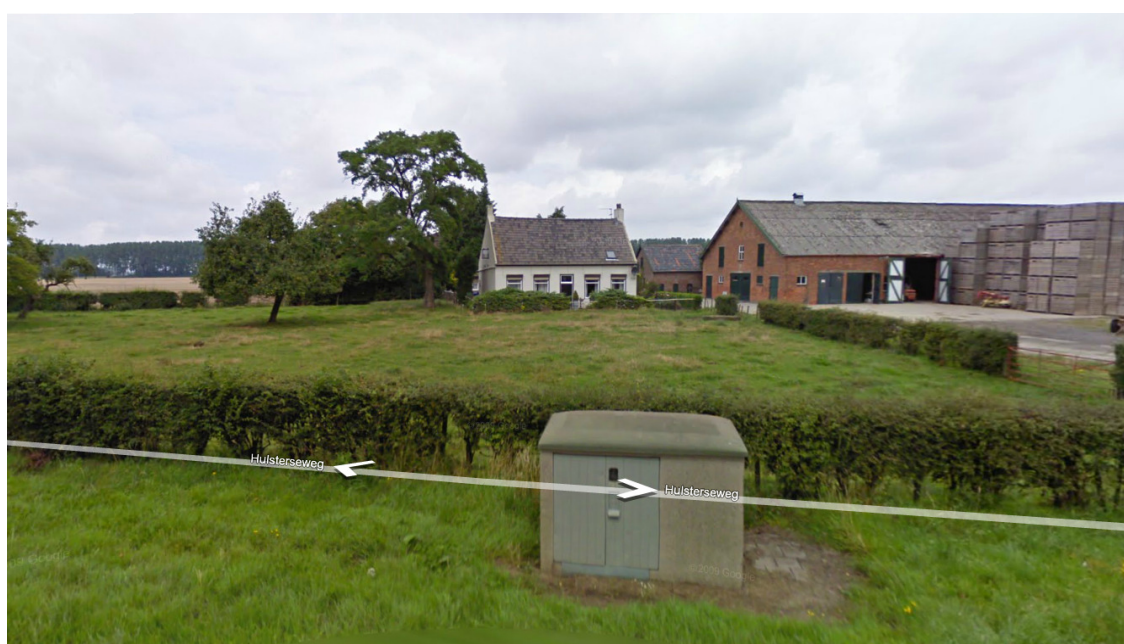
Figuur 2.4 Aanzicht naast gelegen bebouwing
